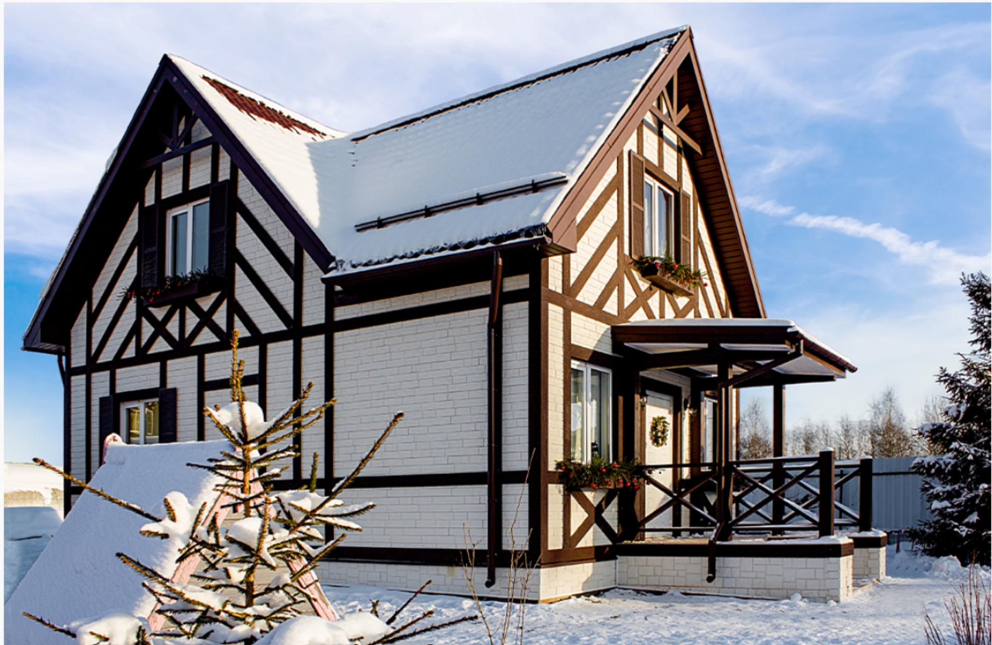
**Фасадные панели** – это современный облицовочный материал из полипропилена, который реалистично повторяет текстуру кирпичной кладки и дикого камня с помощью технологии HD Realistic Touch Feeling. Формы, разработанные в Канаде и Германии, содержат неповторяющиеся детали менее 0,1 миллиметра, воссоздающие природный рисунок материалов.
