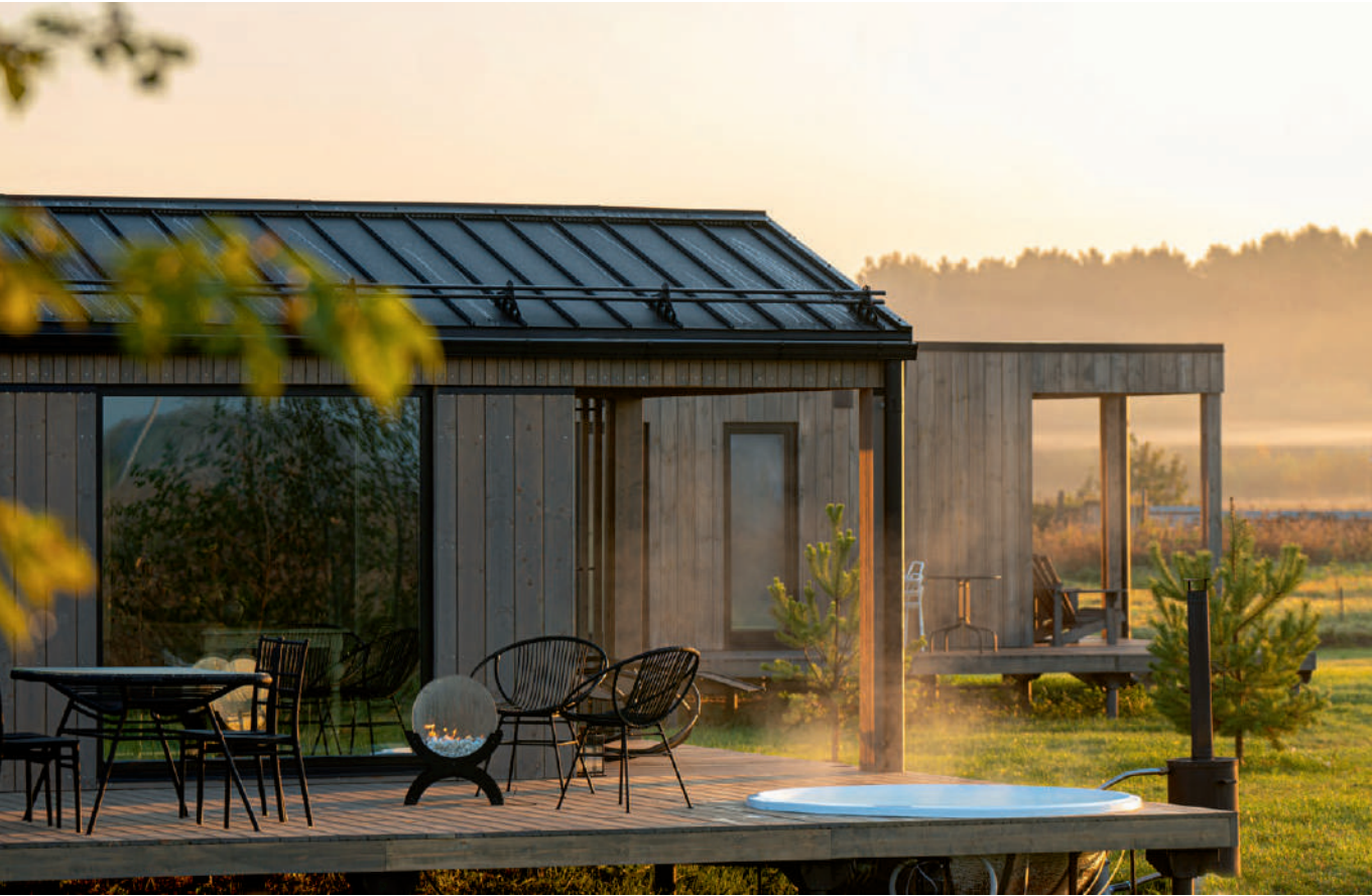
Кликфальц® Pro Drap, RAL 9005 Снегозадержатели для фальцевой кровли Grand Line, RAL 9005 Металлический водосток Vortex Matt, RAL 9005 Объект Scout House
