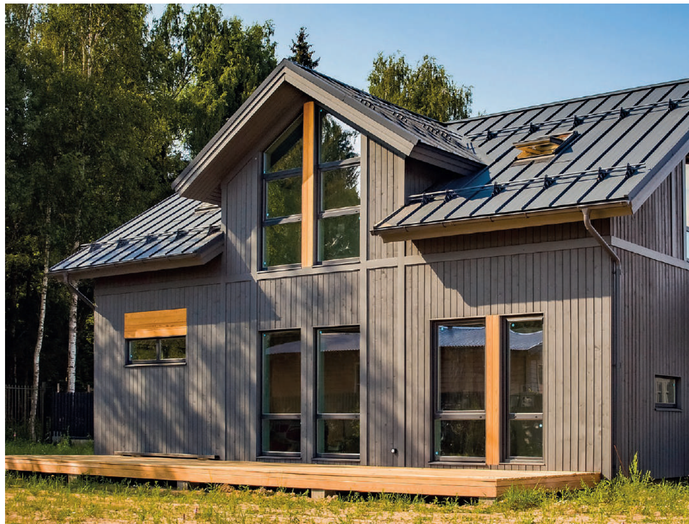
Кликфальц® Pro Line Rooftop Бархат, RAL7024 Снегозадержатели для фальцевой кровли Grand Line, RAL7024 Металлический водосток Grand Line PU, RAL7024 Объект Izburg
