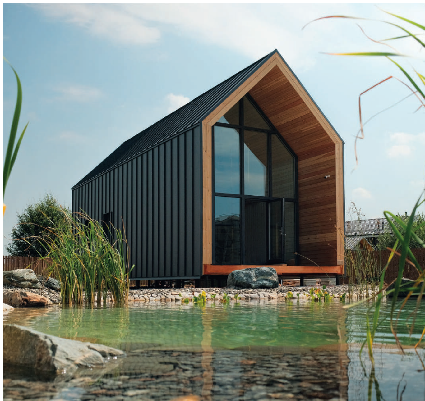
Кликфальц® Pro Rooftop Бархат, RAL7024 Объект OKprefab
