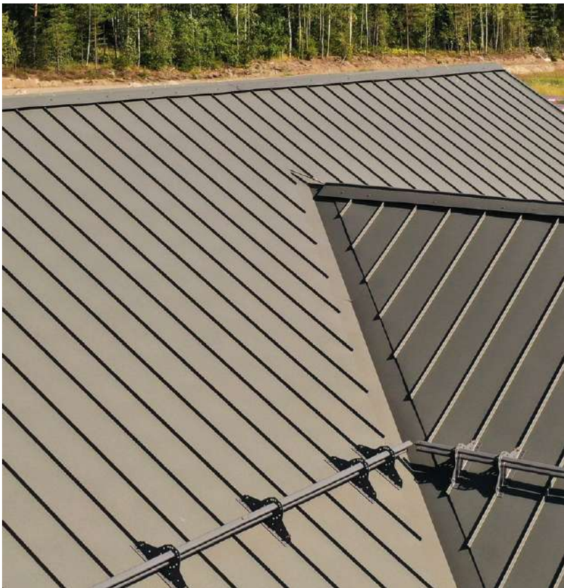
Кликфальц® Mini Drap TX, RR32 Снегозадержатели для фальцевой кровли Grand Line, RR 32 Объект Бригадапрофи
