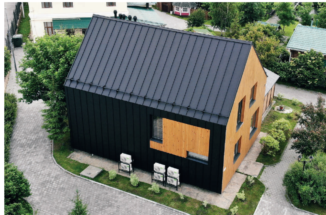
Кликфальц® Pro Drap, RAL7024 Снегозадержатели для фальцевой кровли Grand Line, RAL 7024 Объект ДОМОУ
