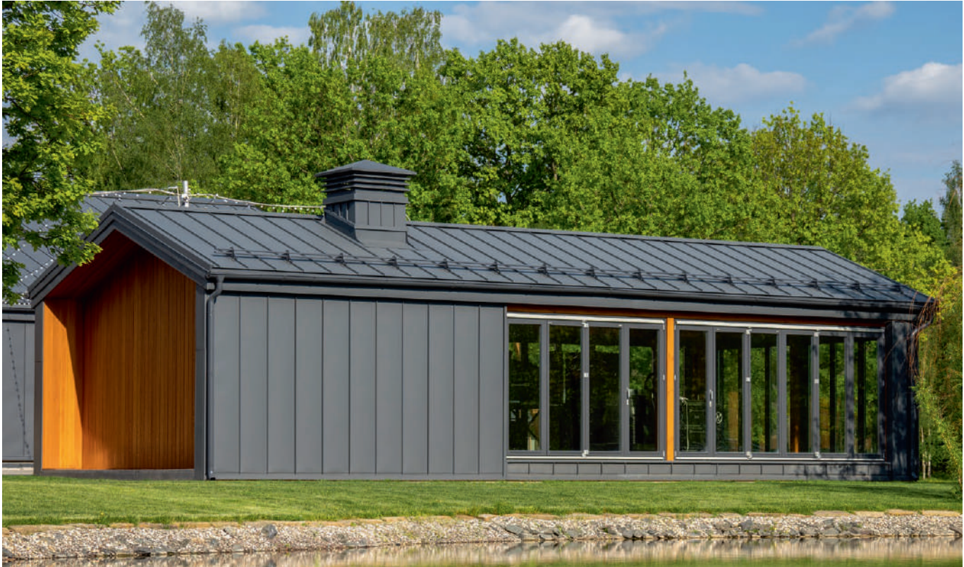
Кликфальц® Pro PurLite Matt, RAL 7024 Снегозадержатели для фальцевой кровли Grand Line, RAL 7024 Металлический водосток Grand Line PU, RAL 7024 Объект ДДМ-Строй
