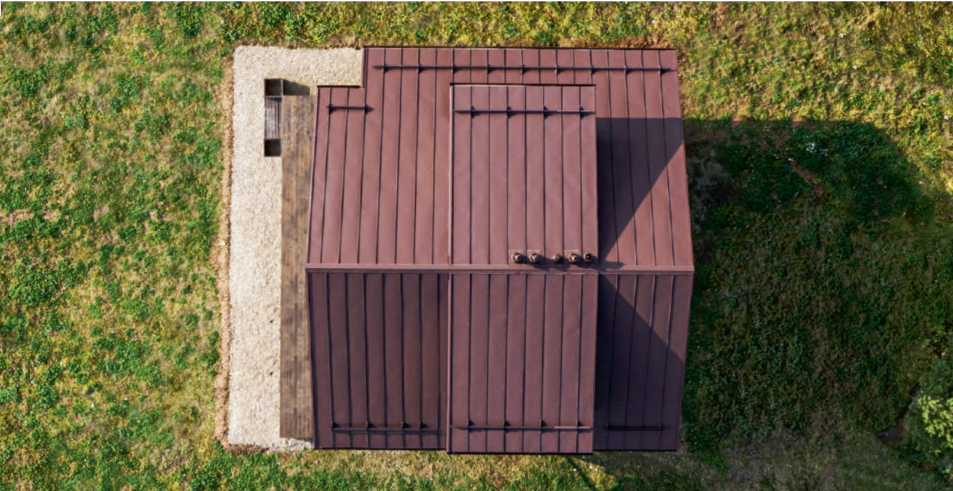
Кликфальц® Drap, RAL 8017 Снегозадержатели для фальцевой кровли Grand Line RAL 8017 Металлический водосток Grand Line PU, RAL 8017 F&M House
