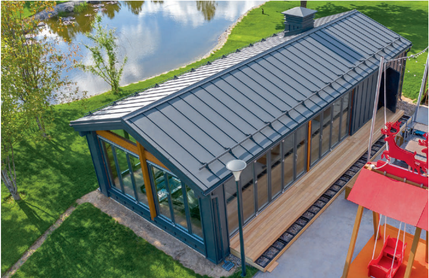
Кликфальц® Pro PurLite Matt, RAL7024 Снегозадержатели для фальцевой кровли Grand Line, RAL 7024 Металлический водосток Grand Line PU, RAL 7024 Объект ДДМ-строй
