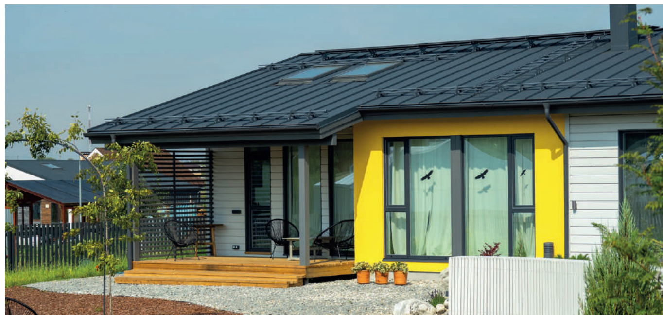
Кликфальц® Pro Satin Matt TX, RAL7024 Снегозадержатели для фальцевой кровли Grand Line, RAL7024 Переходные мостики Grand Line, RAL7024 Металлический водосток Grand Line PU, RAL7024 Объект Izburg
