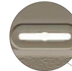
Отверстие под саморез – для безошибочного крепления панели по центру перфорации. «Лепестки» не мешают панели двигаться по резьбе при температурном расширении.
