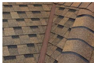
Калифорнийская ендова (один из вариантов открытого способа)
